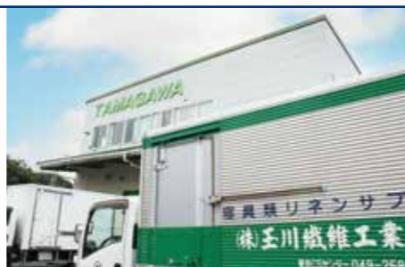
東京CSセンター
